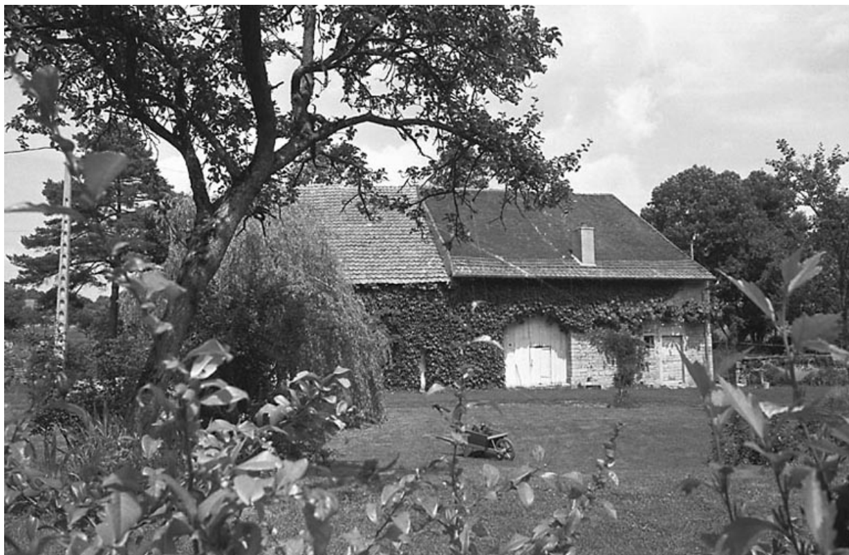
Vue du bâtiment agricole.
