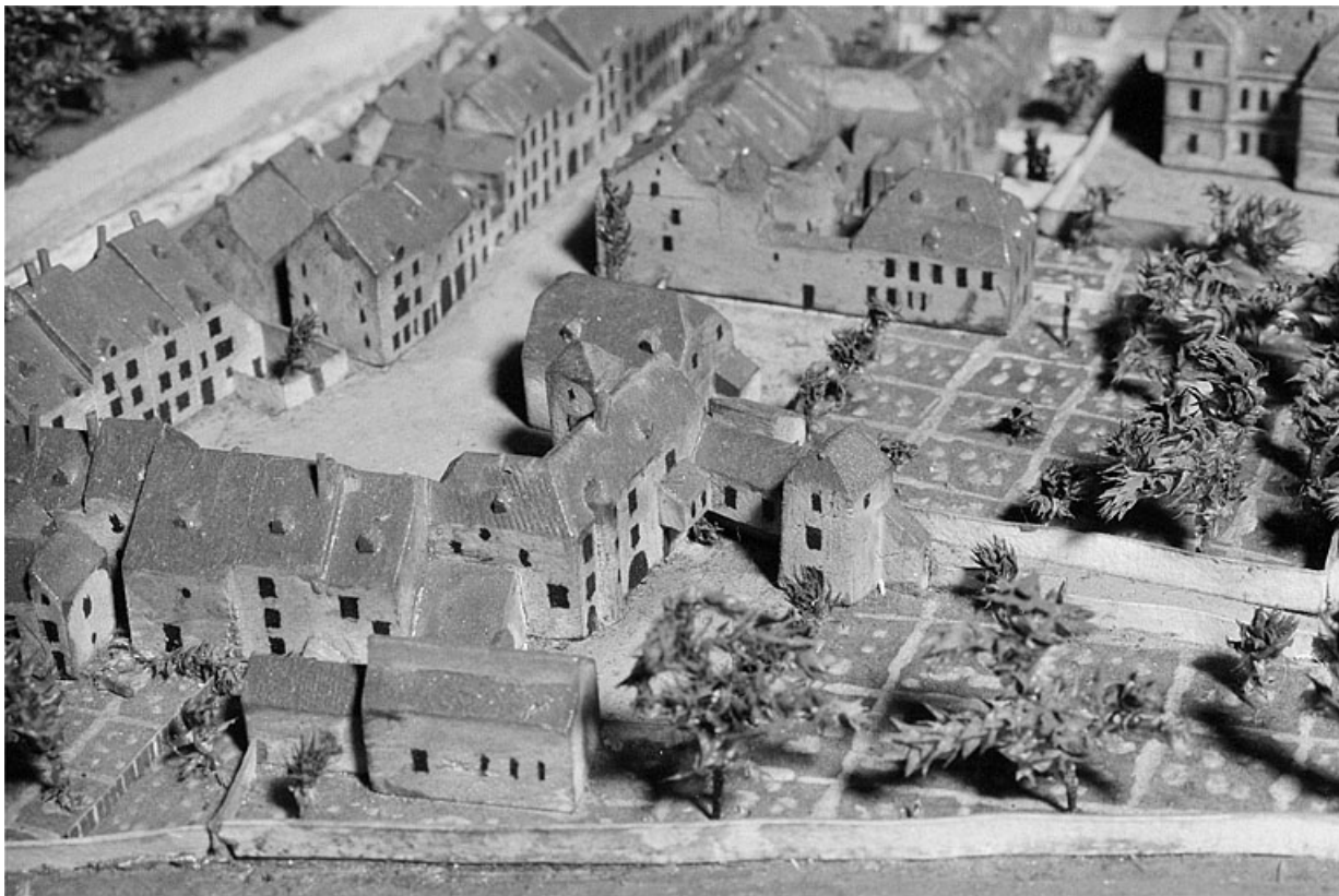
Vue d'ensemble des bâtiments de l'ancien hôtel prise du côté de la cour, 1823-1826. Extrait du plan-relief de 1823-1826, par R.G.I. Wild, échelle 1:1000 (conservé au Musée historique du Vieux Montbéliard).
