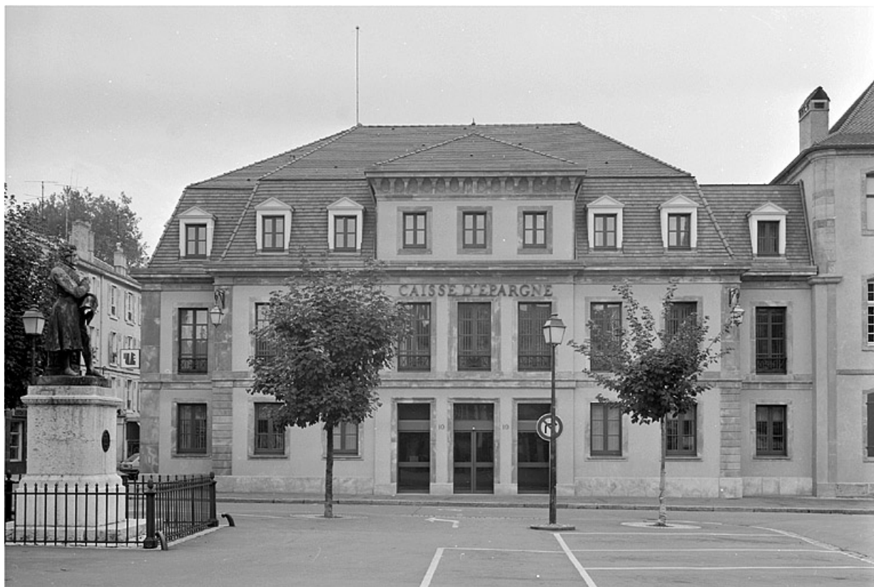
Façade nord après reconstruction.
