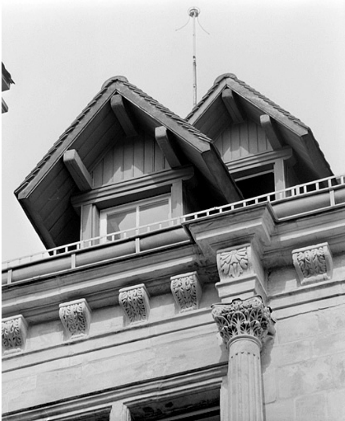
Façade sur la place, troisième étage, détail de l'ordre composite à gauche de la travée centrale. 25, Montbéliard, 21 place Saint-Martin
