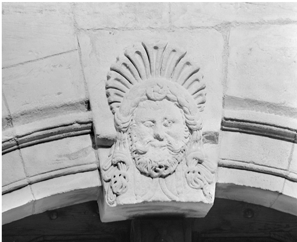
Façade sur la place, clef de l'arc du portail. 25, Montbéliard, 21 place Saint-Martin
