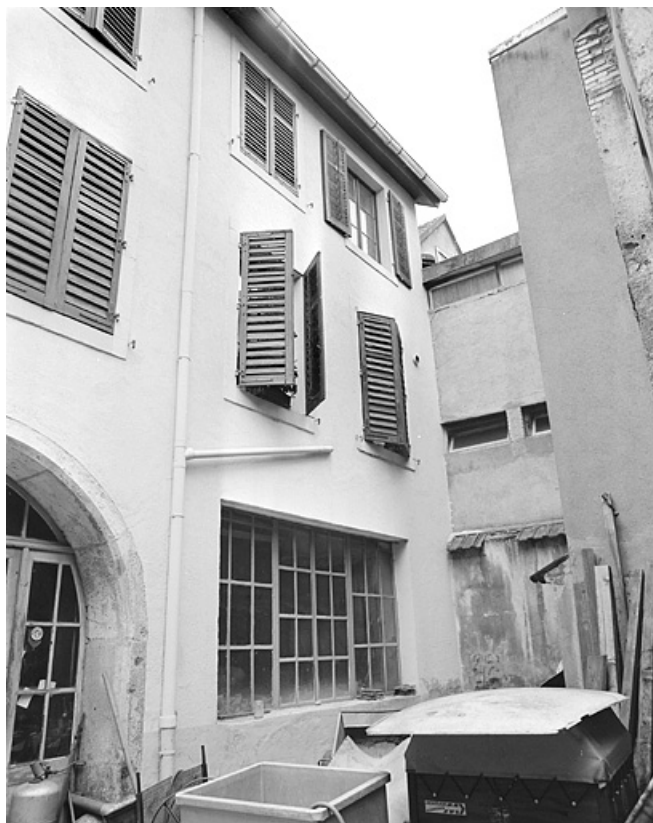
Partie droite de la façade sur cour du corps de bâtiment principal.
