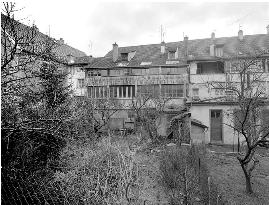
Façade arrière du corps de bâtiment principal et jardin.
