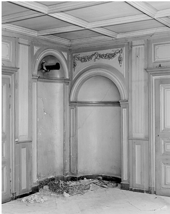
Niches de l'ancien poêle de la pièce principale.
