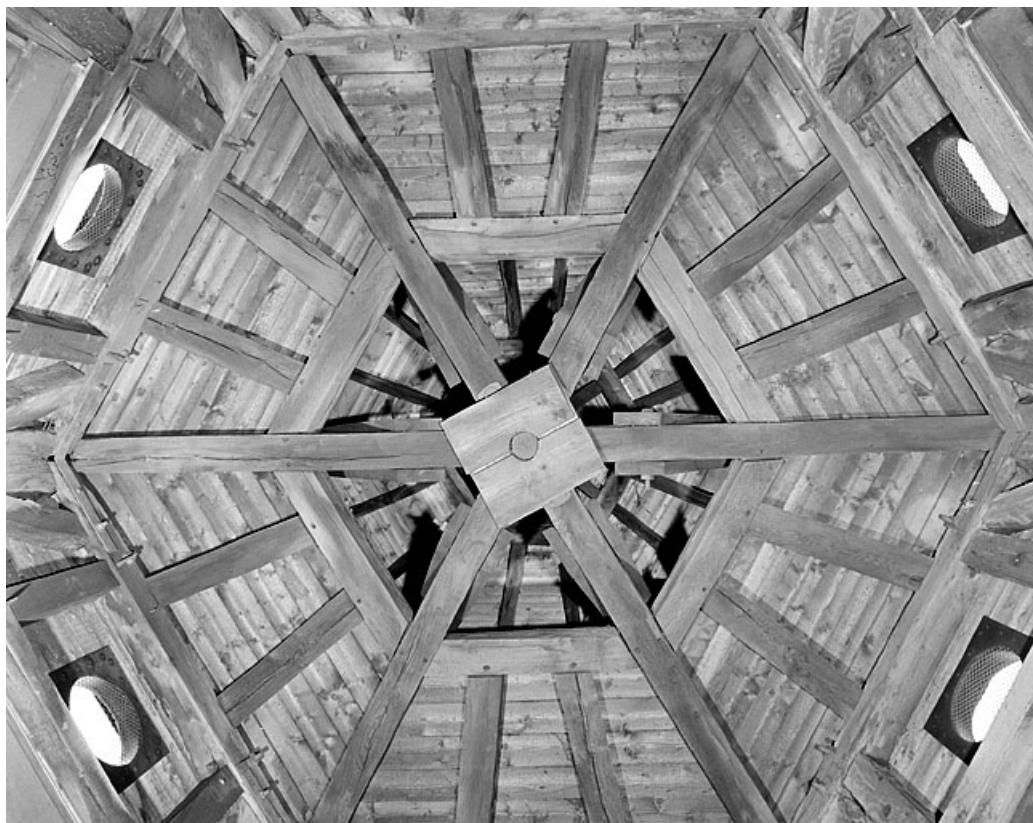
Tour Henriette. Charpente du lanternon. 25, Montbéliard cour du Château
