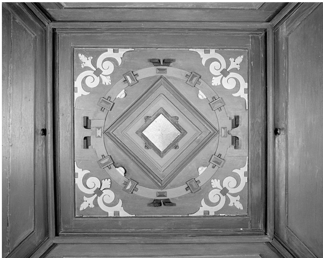
Tour Henriette. Pièce du quatrième niveau. Détail du plafond.
