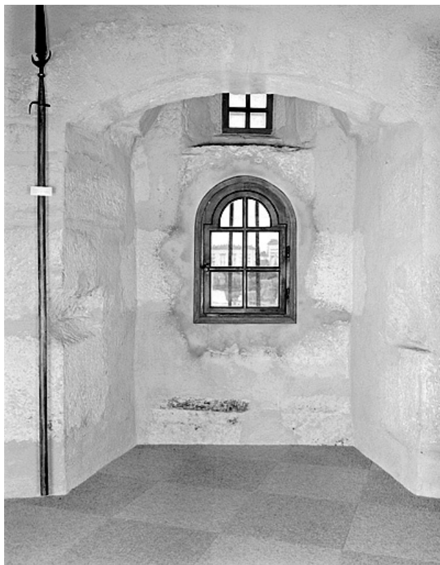
Tour Henriette. Fenêtre du troisième niveau.
