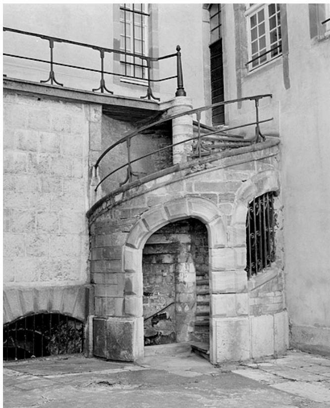
Cour de l'Ours. Escalier de la coursière. 25, Montbéliard cour du Château
