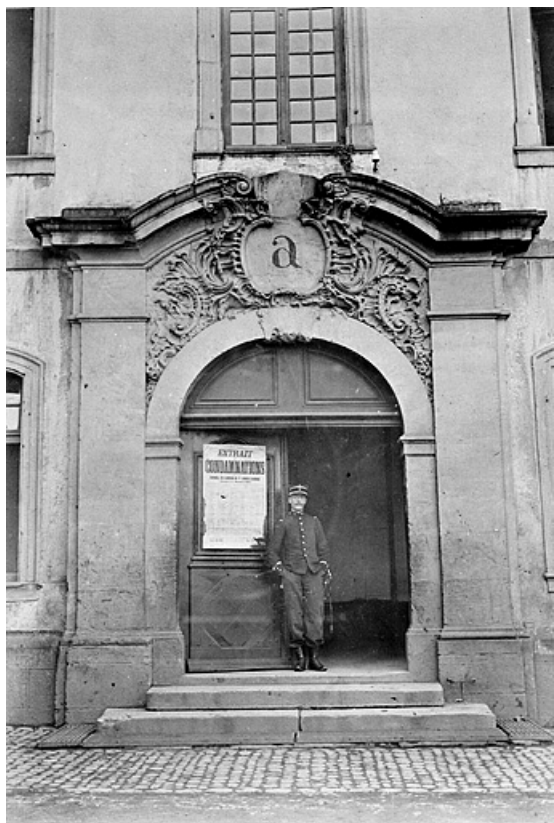
Portail du corps de bâtiment principal, fin 19e siècle. 25, Montbéliard cour du Château
