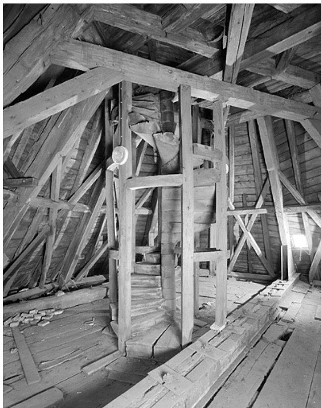
Tour Henriette. Charpente et escalier conduisant au lanternon. 25, Montbéliard cour du Château
