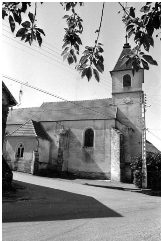
Façade latérale gauche.
