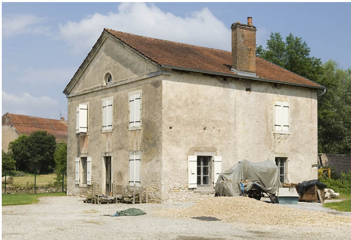
Logement patronal vu de trois quarts en 2008.
