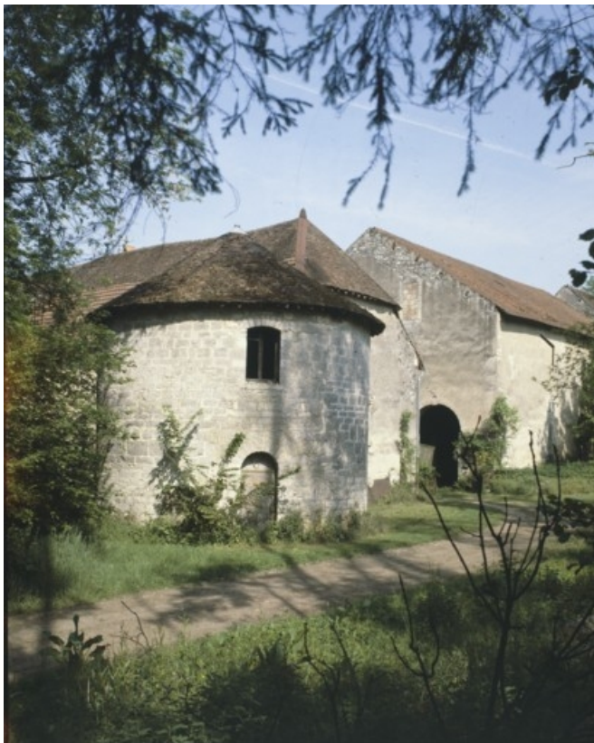
Façade postérieure de l'ancien logis seigneurial : détail d'une tour d'angle. 70, Valay, 9 rue du Vieux Château, lieudit : Petit Valay
