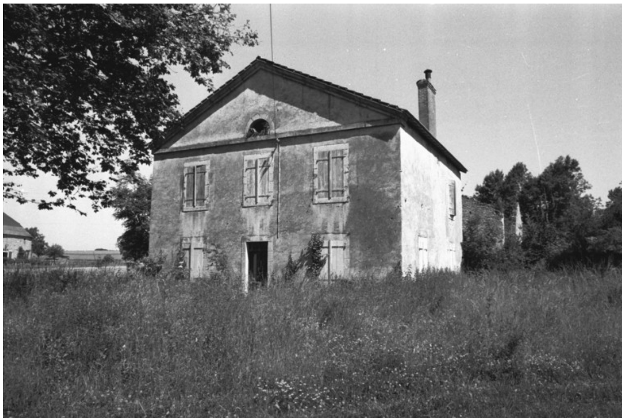
Logement patronal. Vue de trois quarts en 1981.
