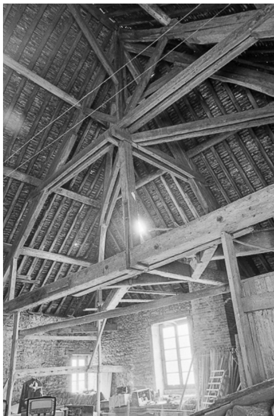
La charpente du haut fourneau en 1979.
