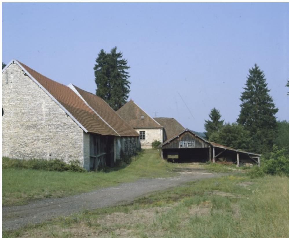
Halle à charbon et haut fourneau vus depuis l'est en 1989.
