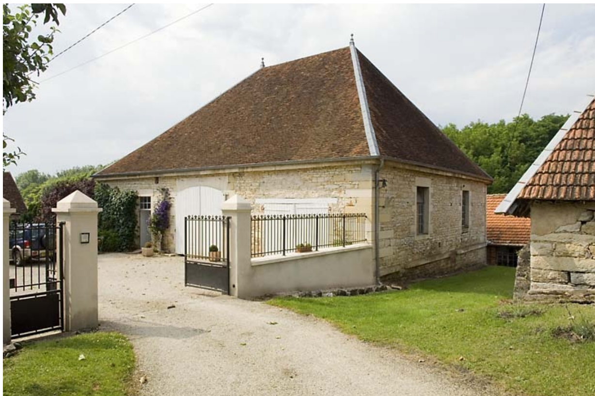
Le haut fourneau vu depuis le sud-est.
