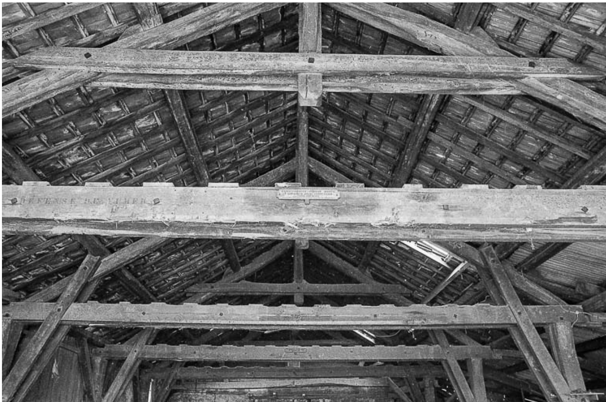
Ferme de la charpente du haut fourneau en 1979.
