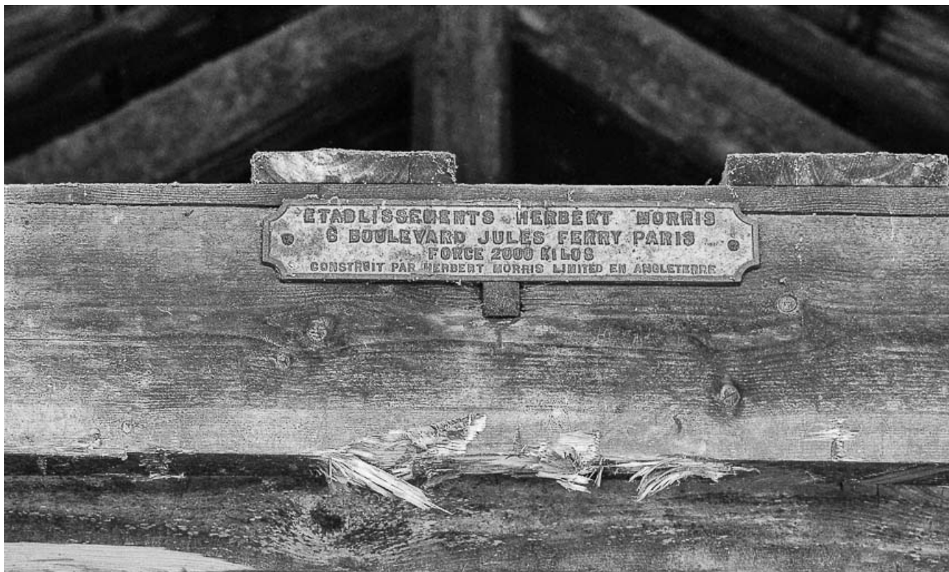
Extrait de la charpente du haut fourneau en 1979. Détail d'une plaque signalétique.
