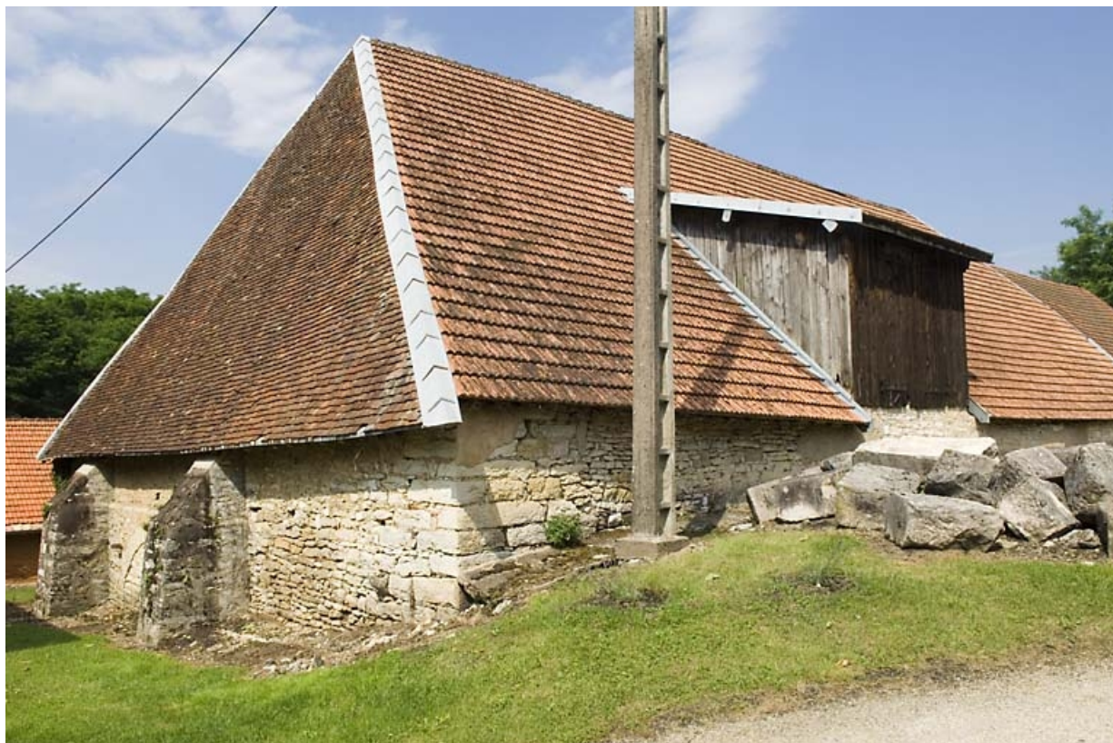
La halle à charbon vue de trois quarts gauche.
