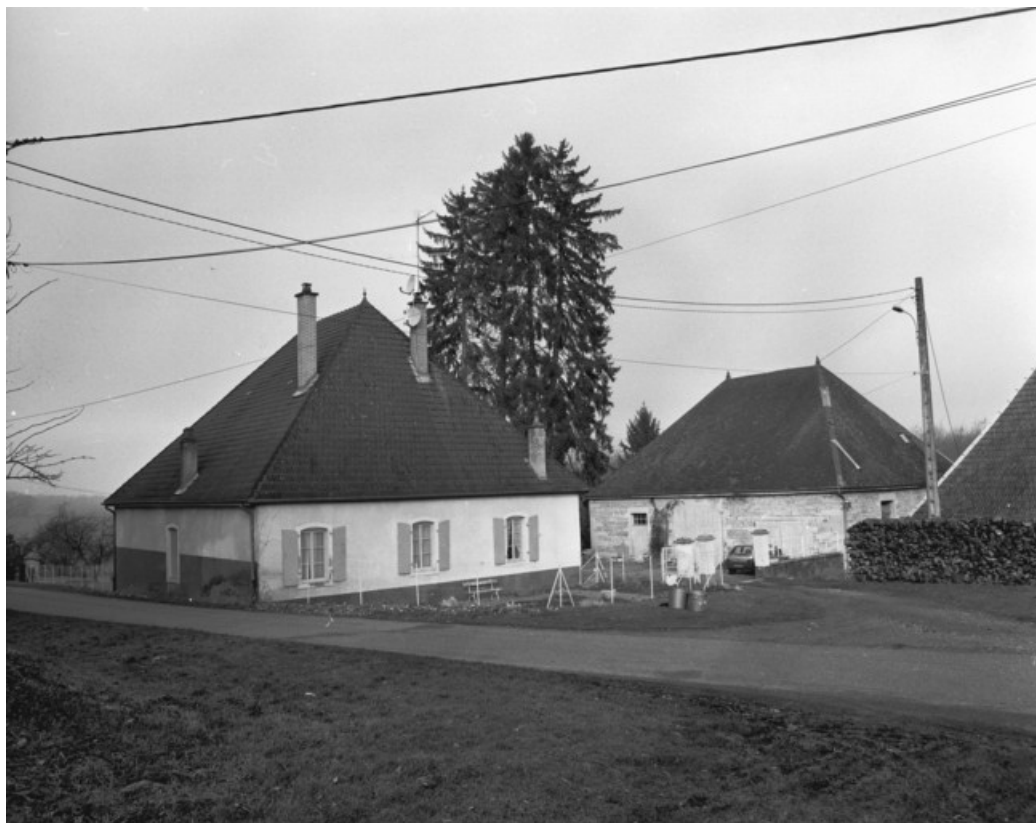
Logement patronal et bâtiment du haut fourneau vus de trois quarts en 1989.
