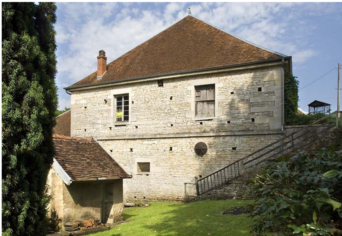
Façade ouest du haut fourneau.
