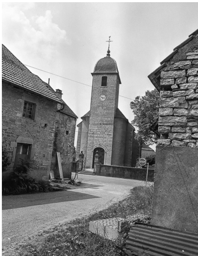
Extérieur : façade antérieure vue éloignée.
