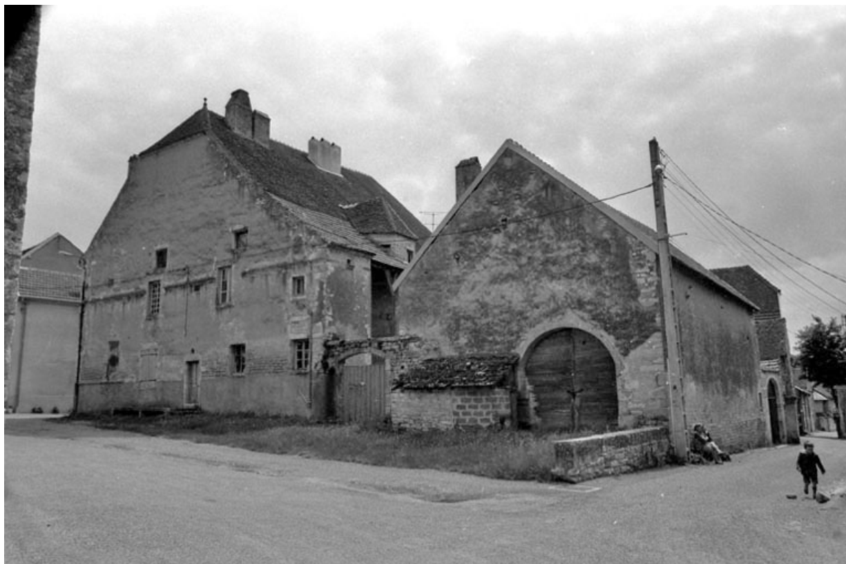
Façade latérale droite et bâtiment agricole.
