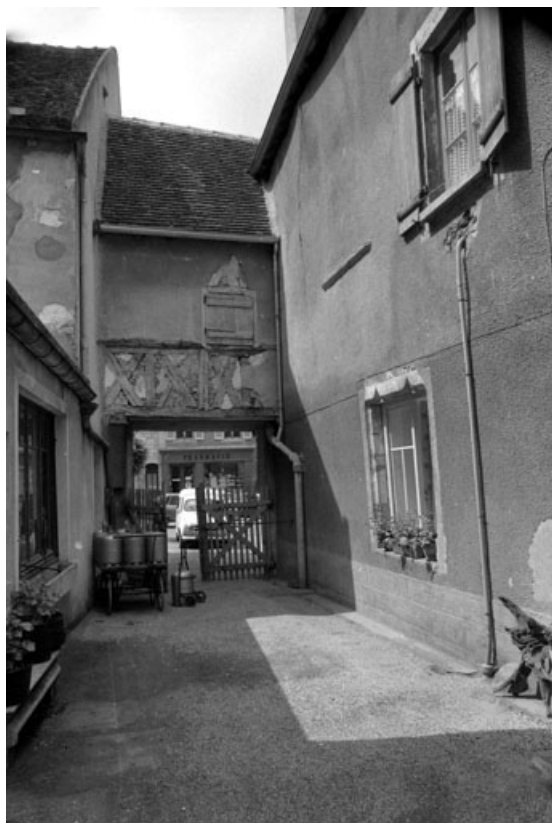
Détail passerelle couverte au-dessus de l'impasse.
