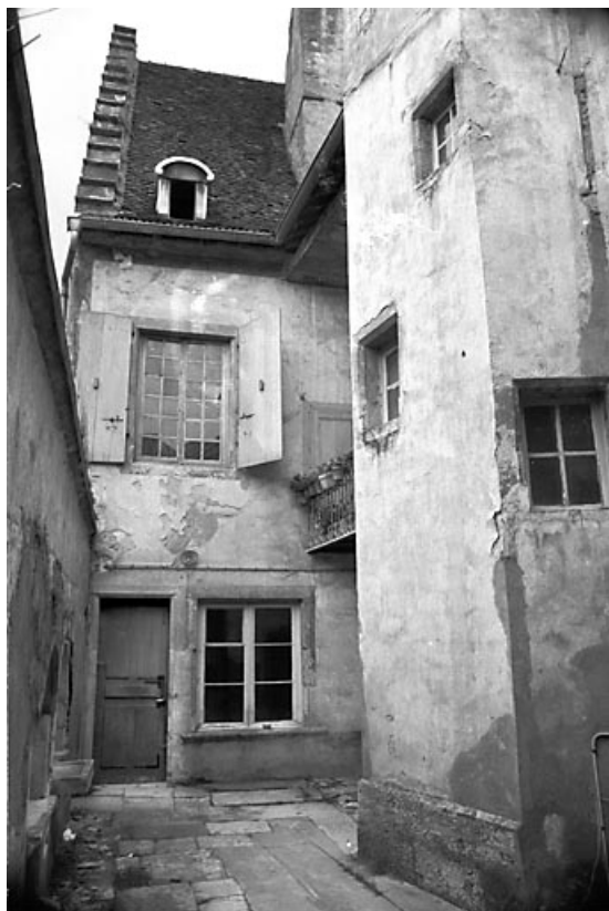
Façade postérieure de l'habitation et tour d'escalier sur cour. 70, Pesmes ruelle Saint-Jacques
