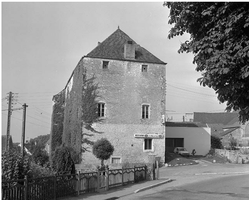
Façade latérale gauche.
