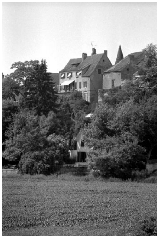
Façade postérieure, vue éloignée.
