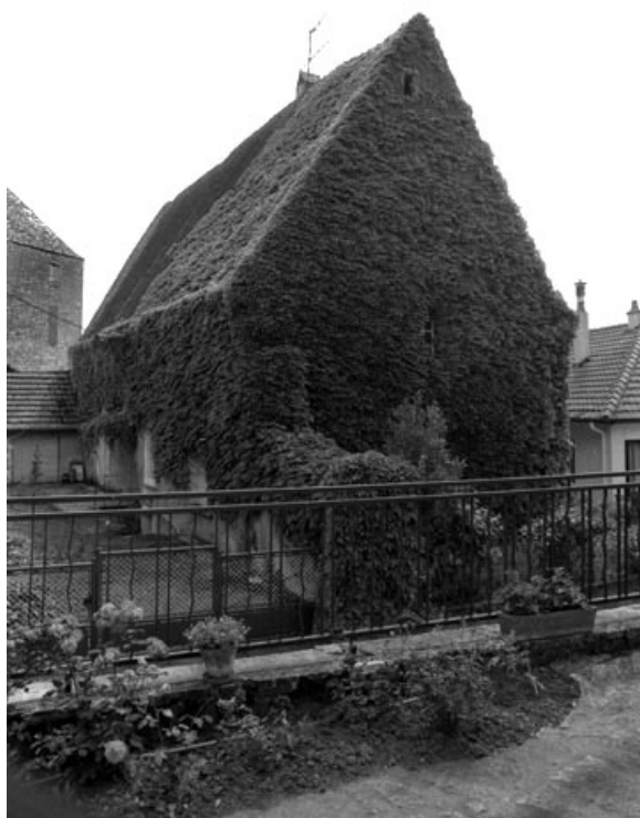
Vue d'ensemble de l'ancienne chapelle.
