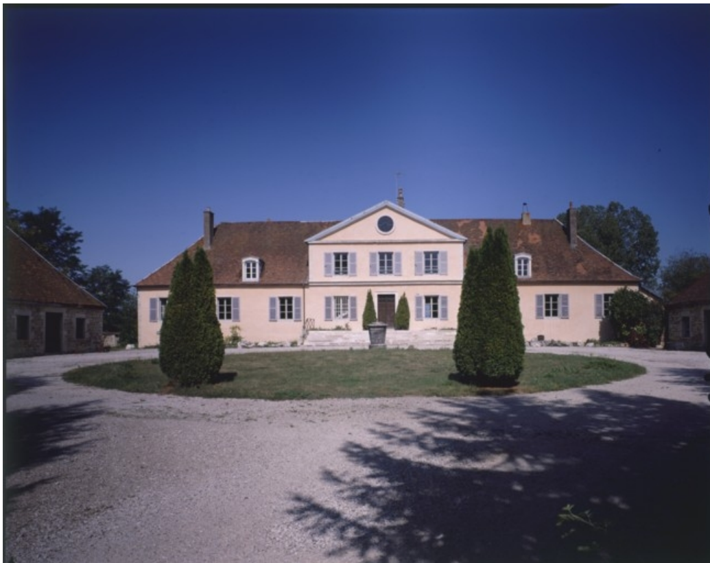
Maison du maître de forges. Façade antérieure en 1992.
