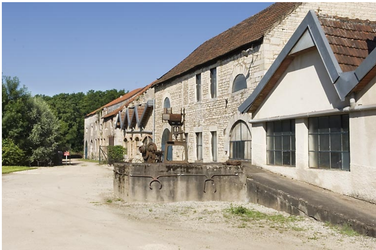
Façades sud des divers ateliers de métallurgie.
