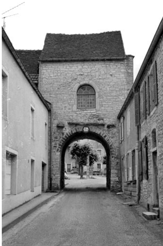
Porte Saint-Hilaire : façade extérieure. 70, Pesmes
