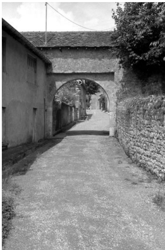
Porte Loigerot : façade extérieure. 70, Pesmes
