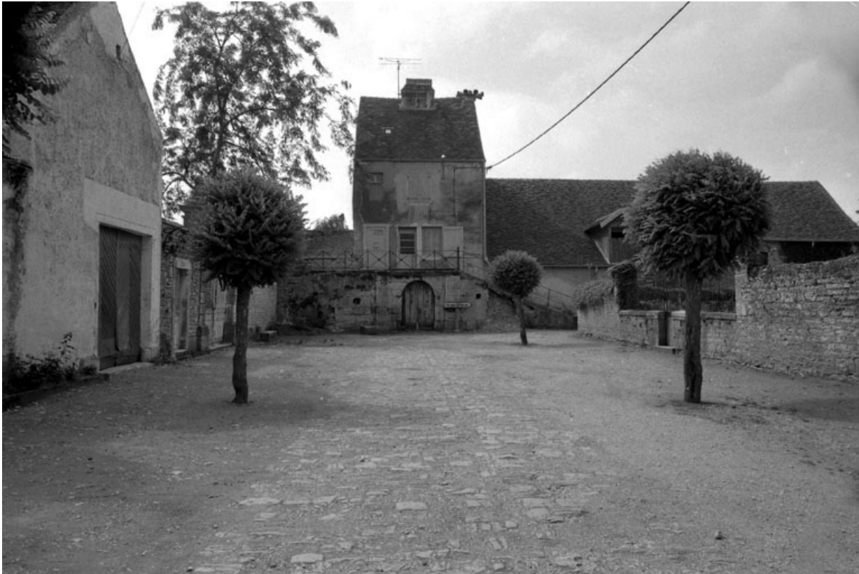
Partie centrale du château depuis la place des promenades.
