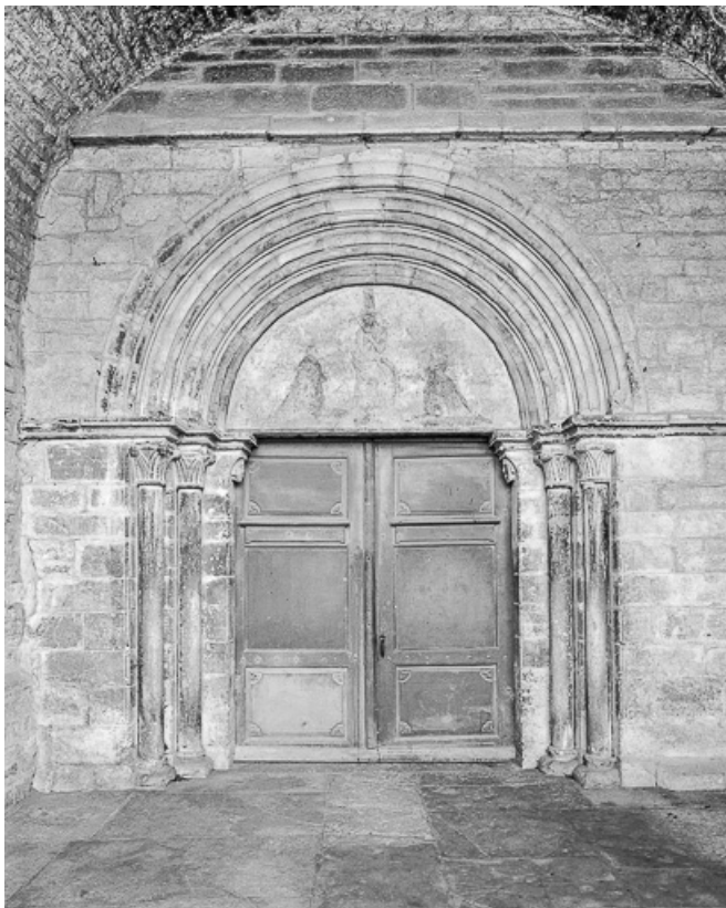
Exérieur : portail ouest.
