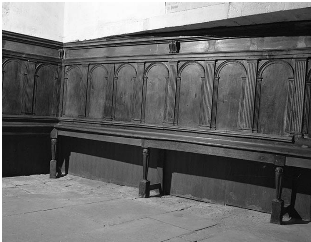
Intérieur : boiseries de la chapelle du baptistère.
