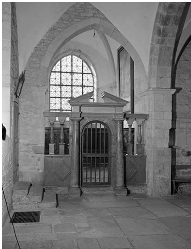
Intérieur : clôture de la chapelle du baptistère.
