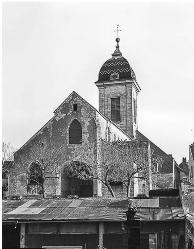
Extérieur : vue d'ensemble depuis le cimetière.
