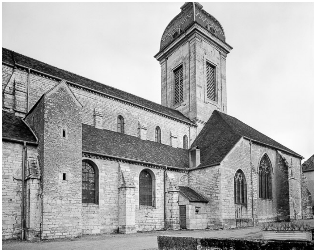
Extérieur : façade latérale sud.
