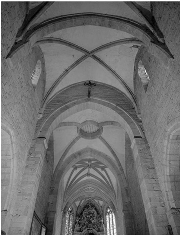
Intérieur : voûtes de la nef et du choeur.
