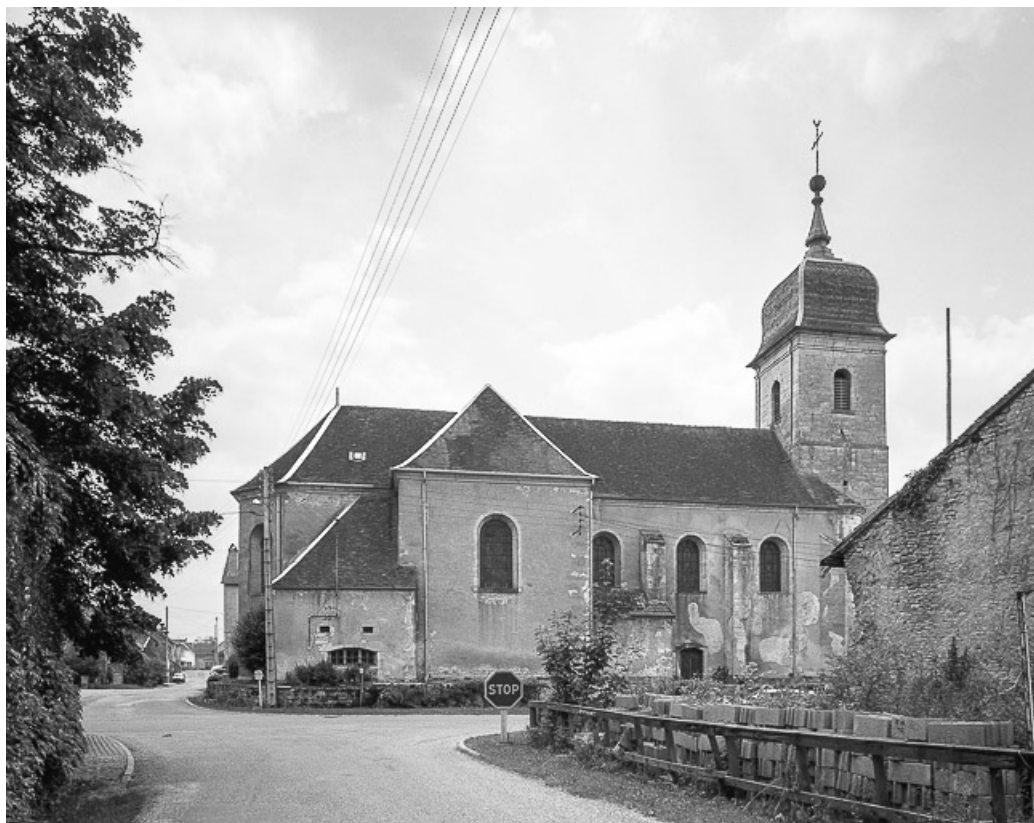
Extérieur : façade latérale gauche.
