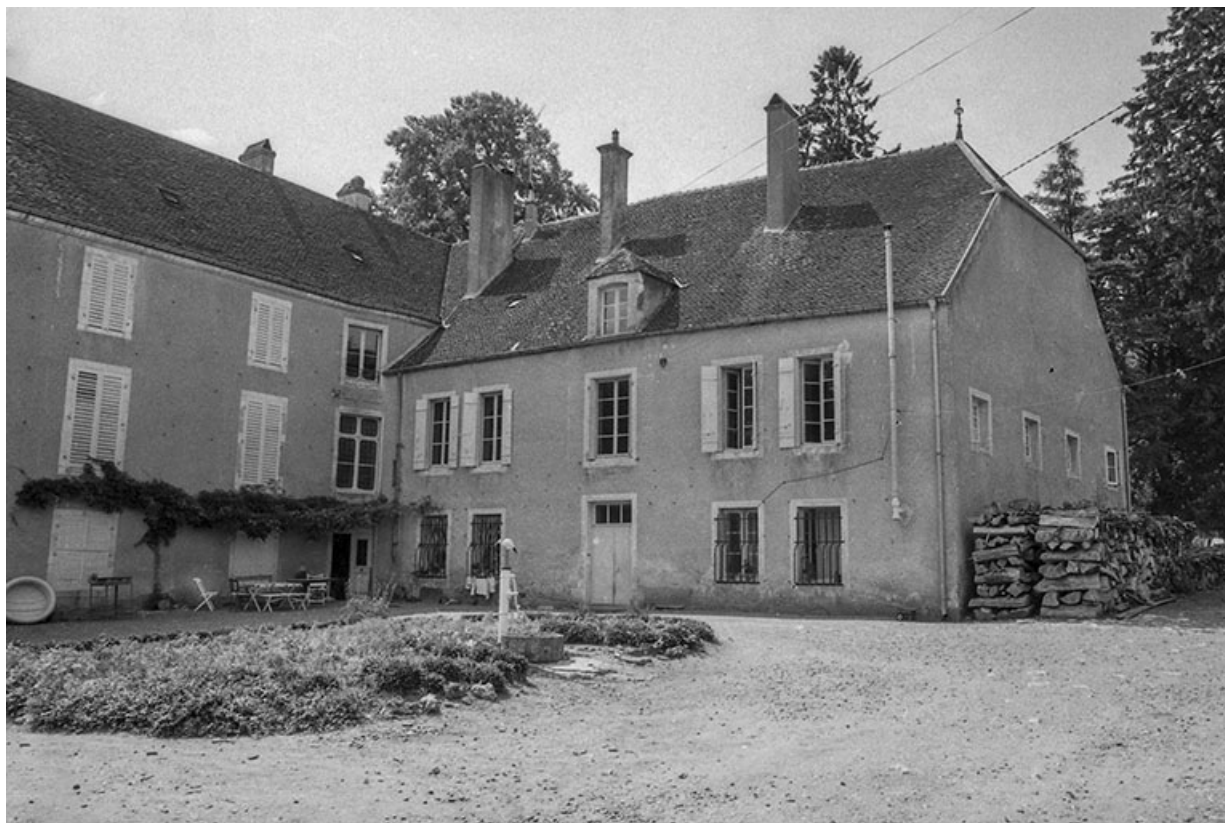
Vue de l'habitation depuis la cour.
