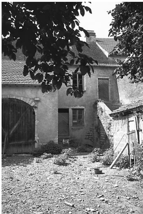
Façade antérieure vue depuis la cour. 70, Malans rue Haute
