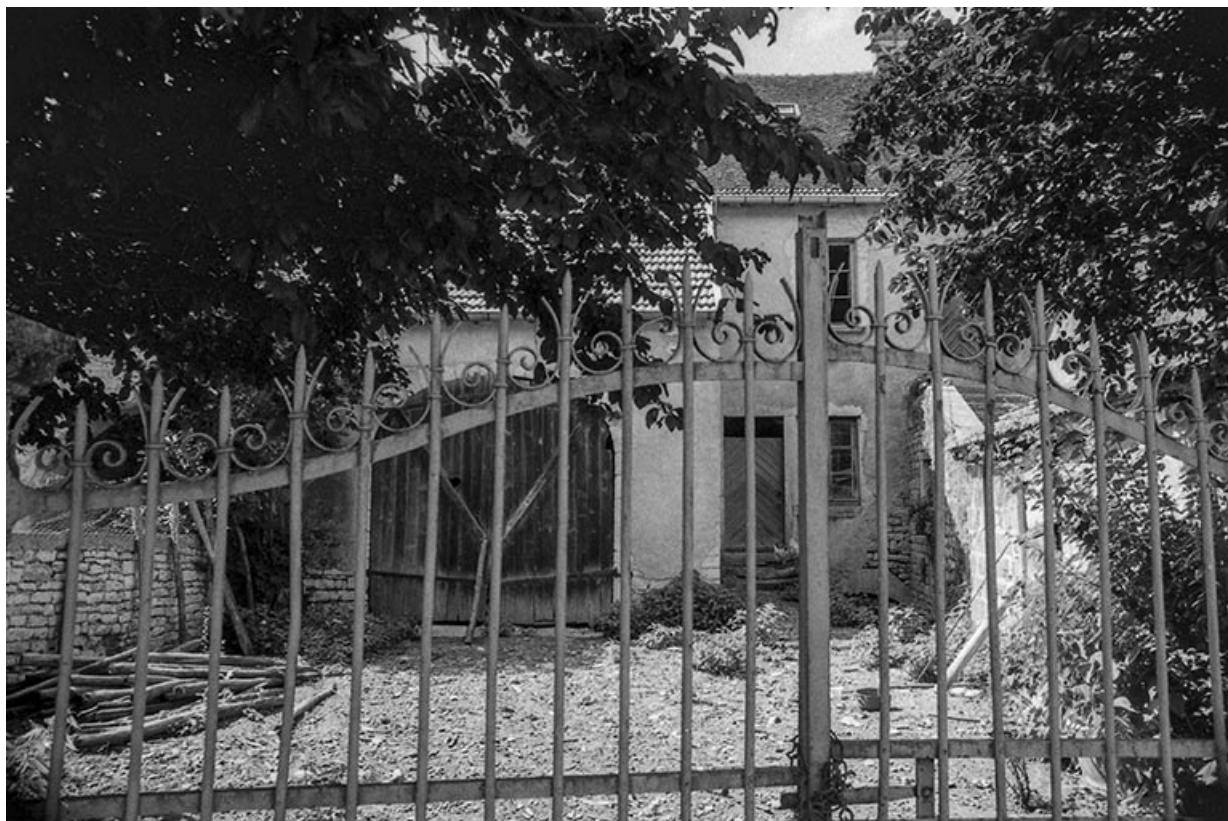
Façade antérieure vue depuis la grille d'entrée. 70, Malans
