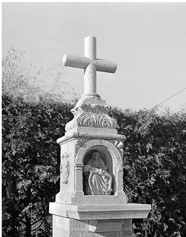
Croix après restauration : partie supérieure.
