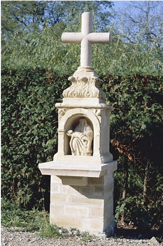
Vue de face après restauration.
