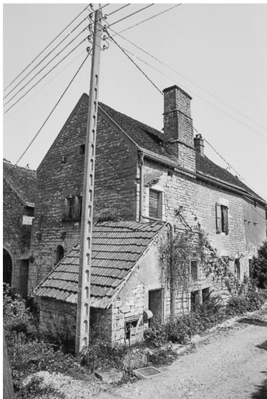
Façade antérieure et latérale gauche.
