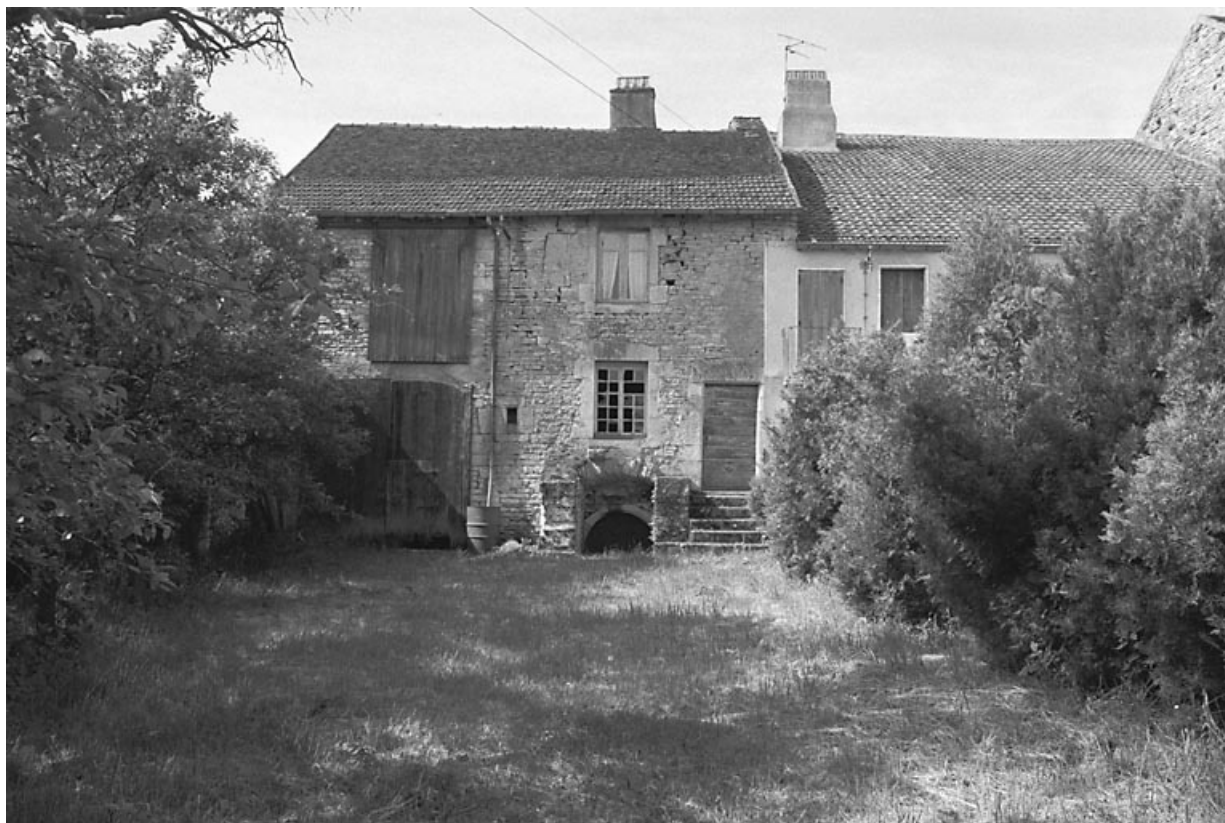
Façade antérieure sur cour.
