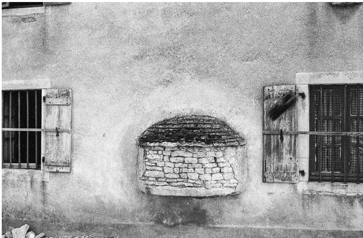
Ferme située 20 route de Pesmes : le four. 70, Chaumercenne
