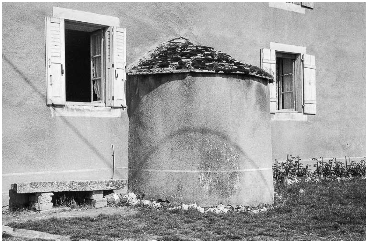
Ferme située 18 route de Pesmes : le four. 70, Chaumercenne
