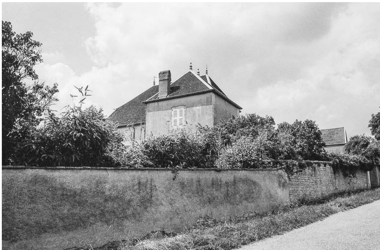
Vue d'ensemble depuis la rue.
