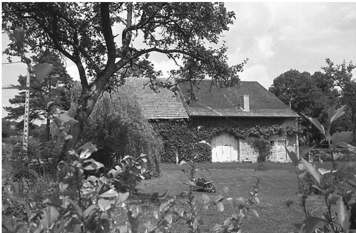
Vue du bâtiment agricole.
