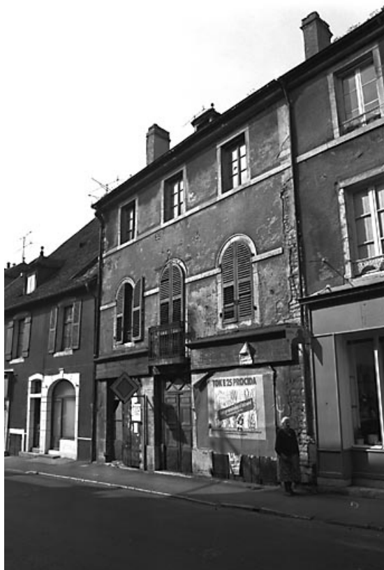
Façade antérieure avec magasins au rez-de-chaussée.
