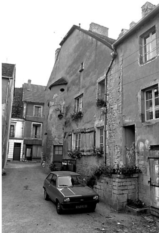
Façade latérale droite sur cour.
