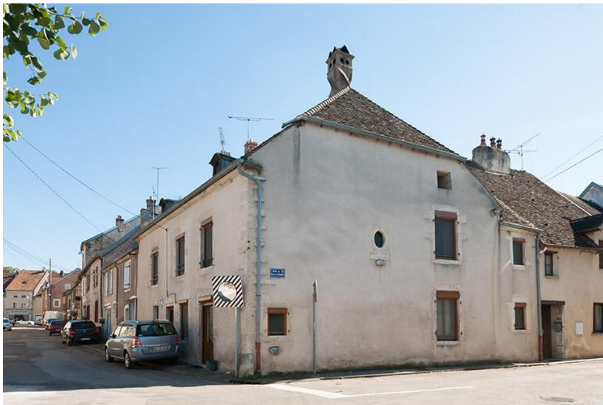
Maison située rue du 10 Septembre 70, Gy
