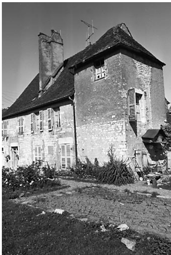
Façade antérieure sur cour de trois quarts droit.
