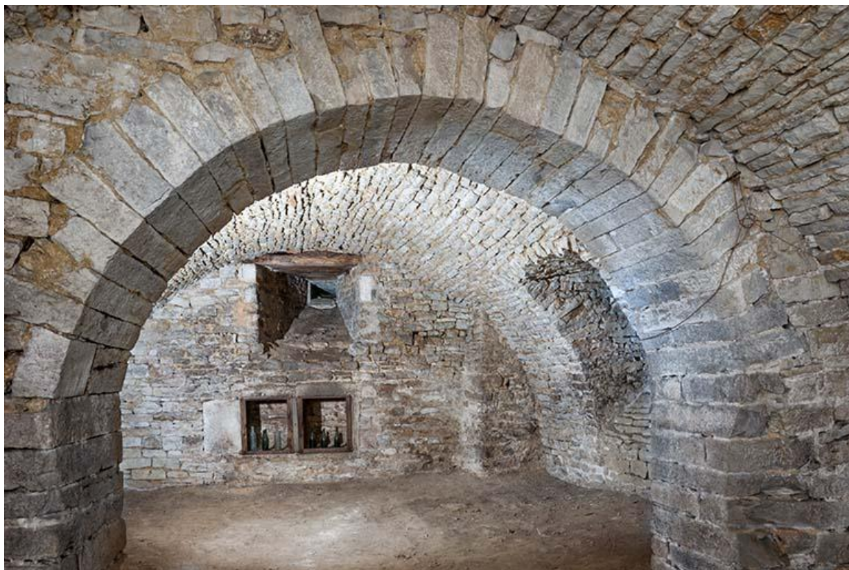
Vue générale de la cave
