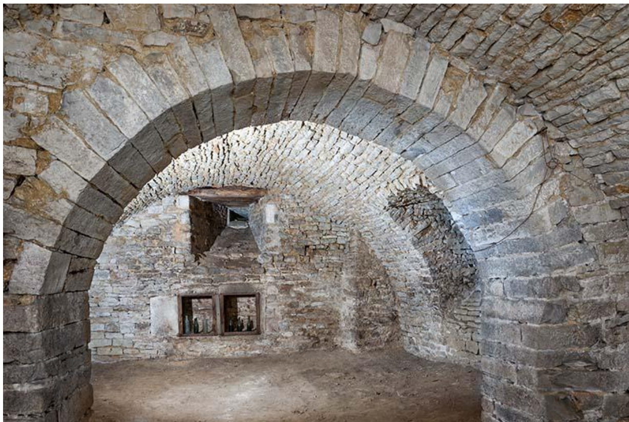
Vue générale de la cave
