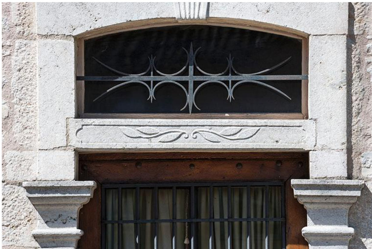
Détail de l'imposte au-dessus de la porte
