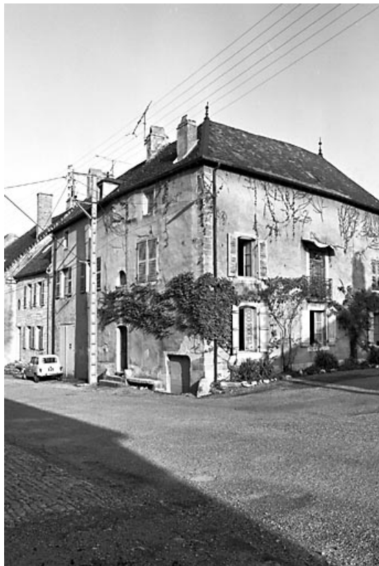
Façades antérieure et latérale droite.
