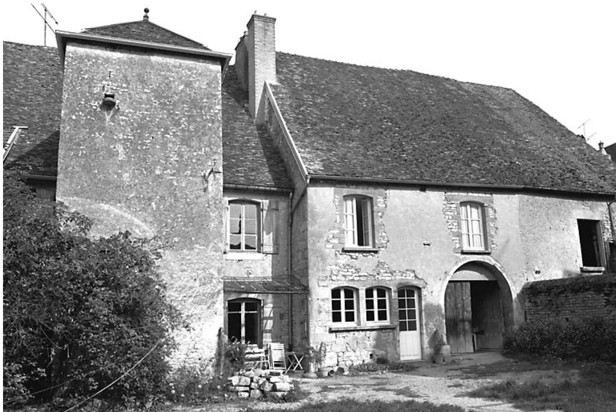
Façade sur cour.
