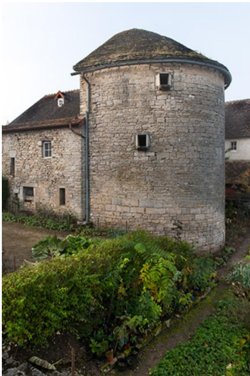
Tour de l'enceinte urbaine
