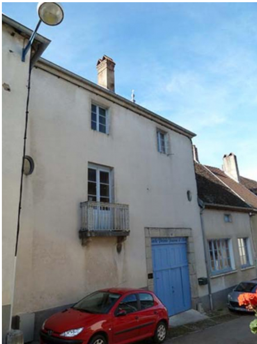
Façade sur la rue du Grand Mont
