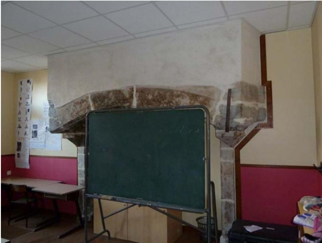
Cheminée monumentale, adossée à la précédente
