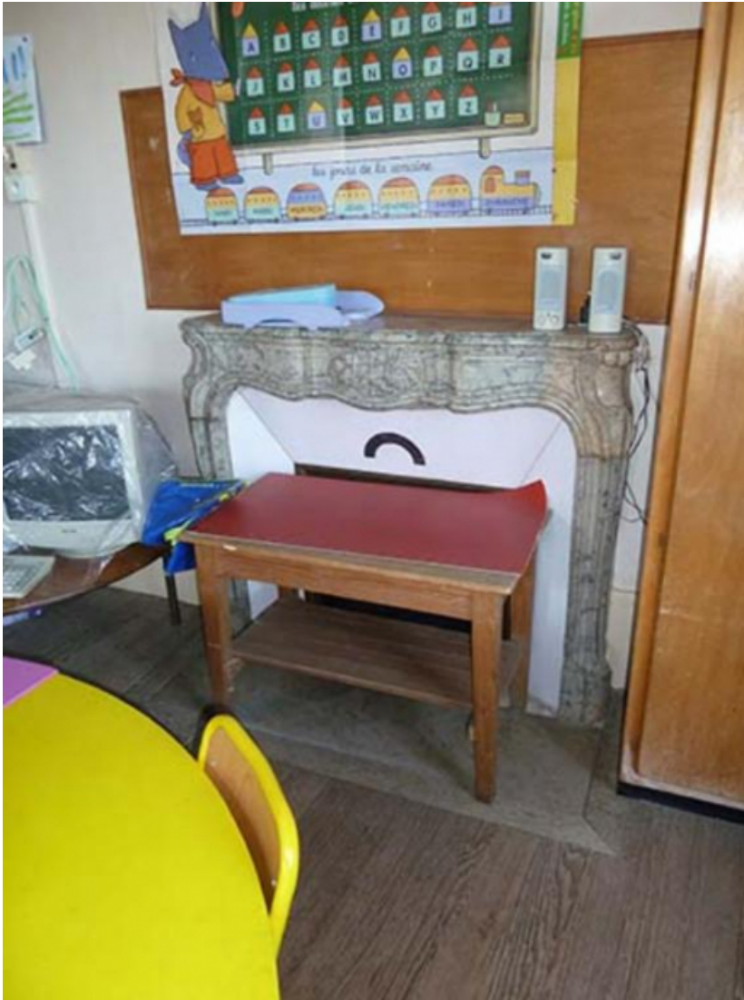
Cheminée en marbre de la partie ouest du bâtiment
