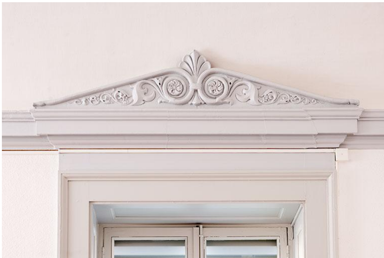
Détail du décor surmontant la baie
