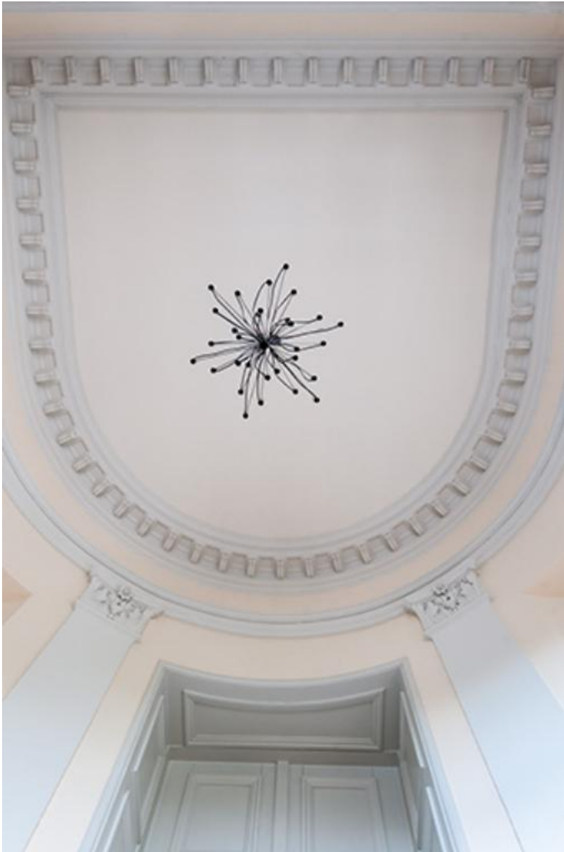
Plafond du vestibule 70, Gy Place de la Mairie
