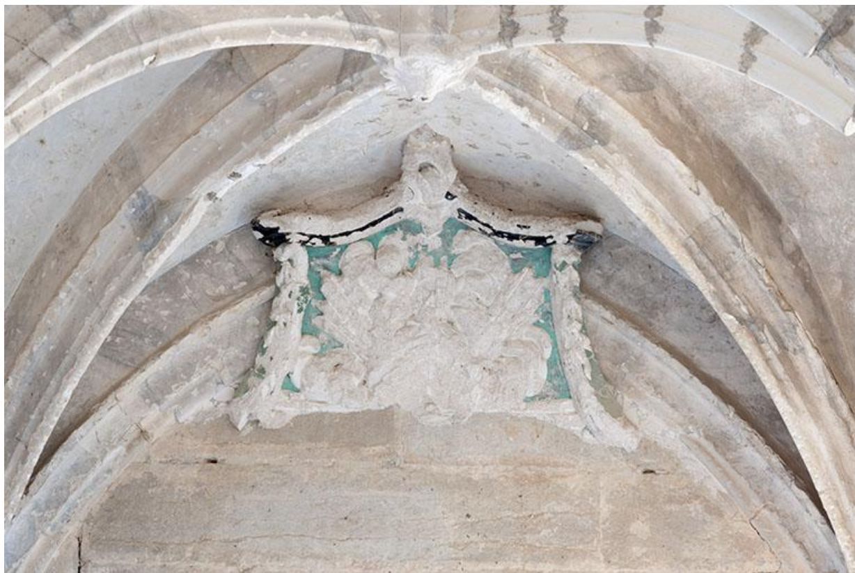
Décor de stuc situé sous la galerie
