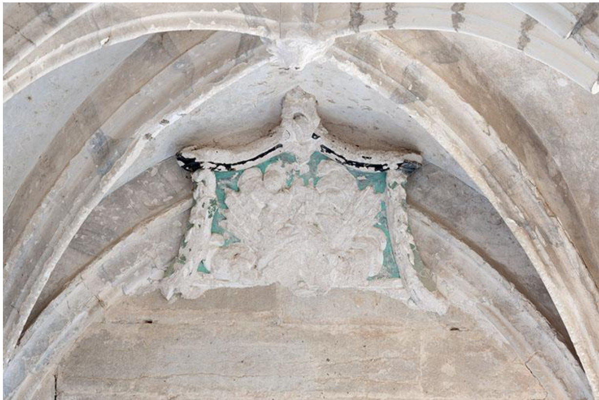
Décor de stuc situé sous la galerie
