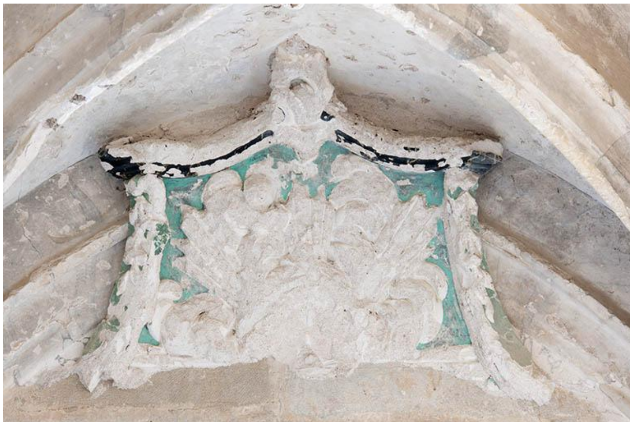
Décor de stuc situé sous la galerie
