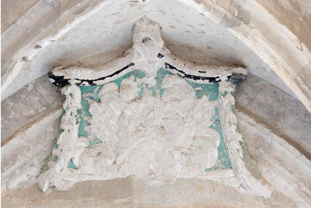
Décor de stuc situé sous la galerie
