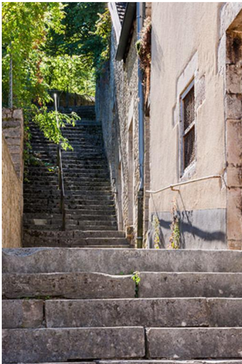
Escalier reliant la Grande Rue au château
