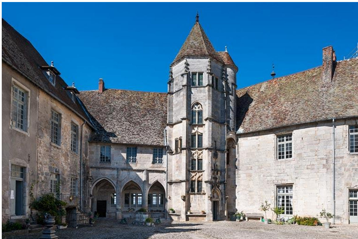
Vue sud depuis l'entrée de la cour
