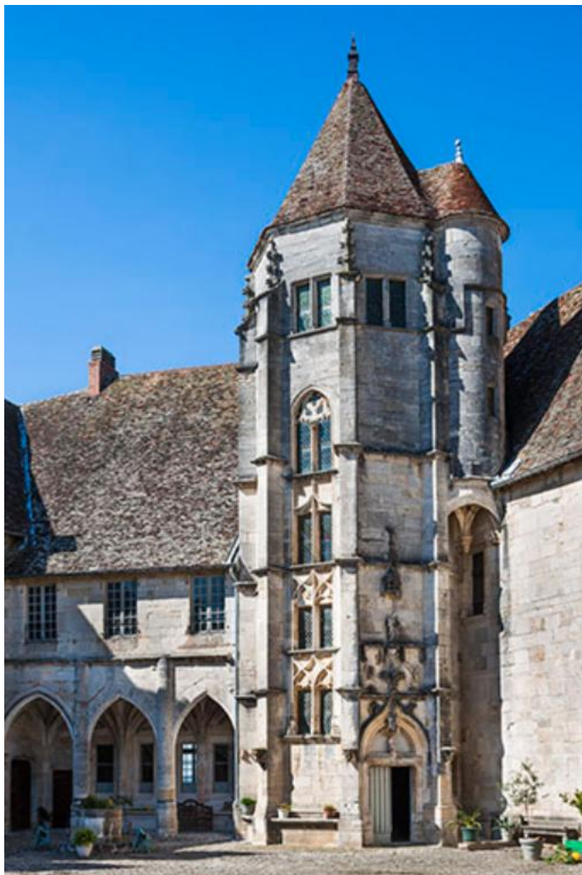
La tour d'escalier
