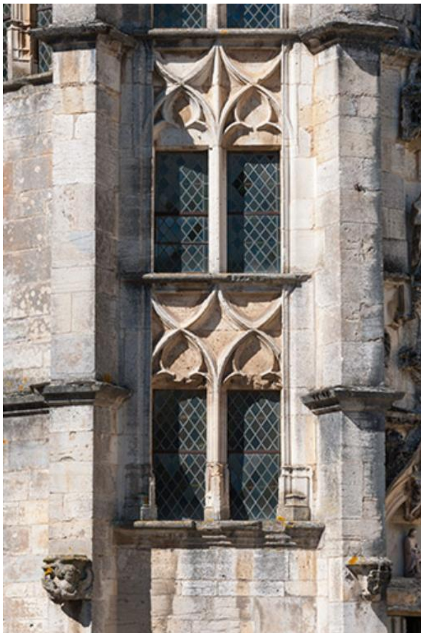
Détail des baies de la tour d'escalier
