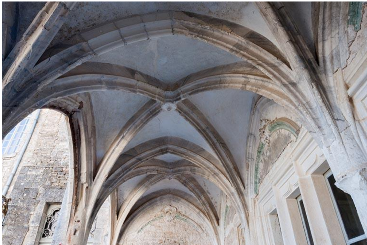
Voutes sur croisées d'ogives de la galerie 70, Gy rue du Château
