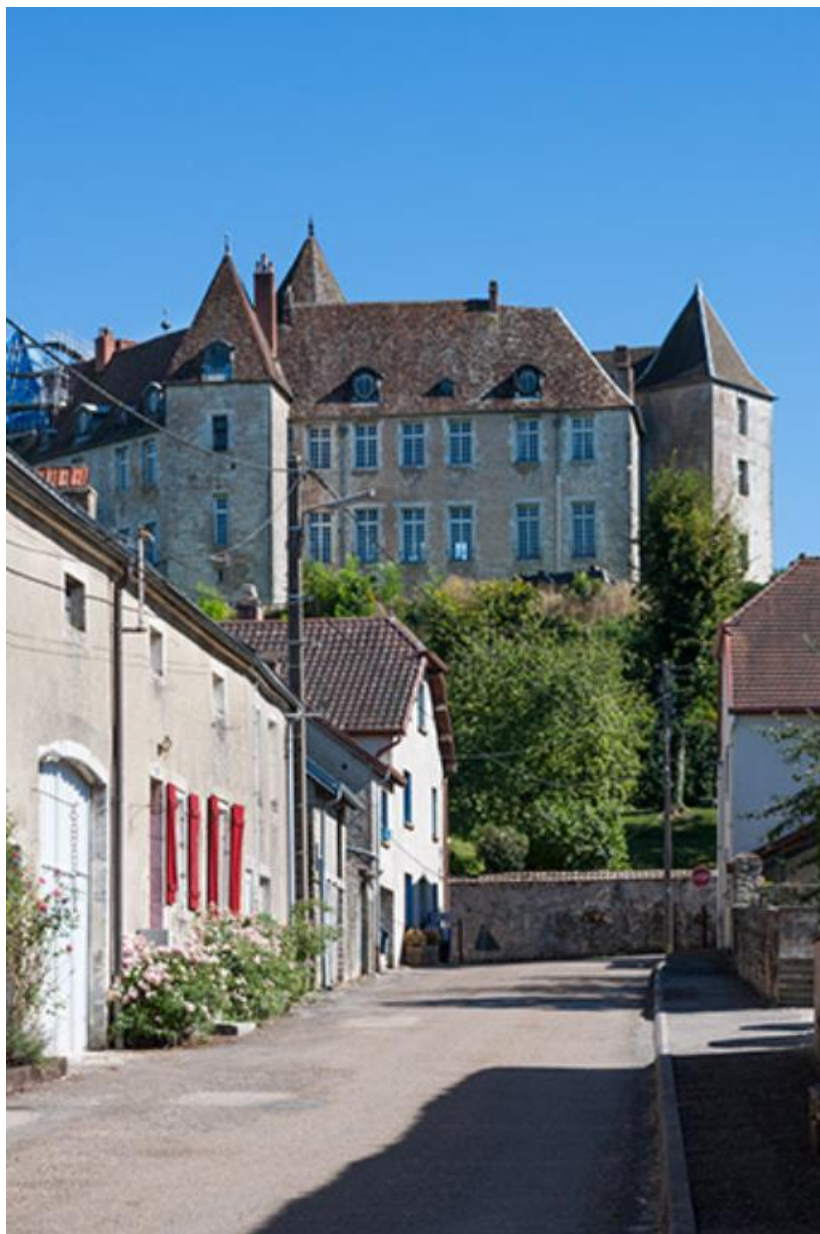
Vue nord, depuis la rue des Terreaux
