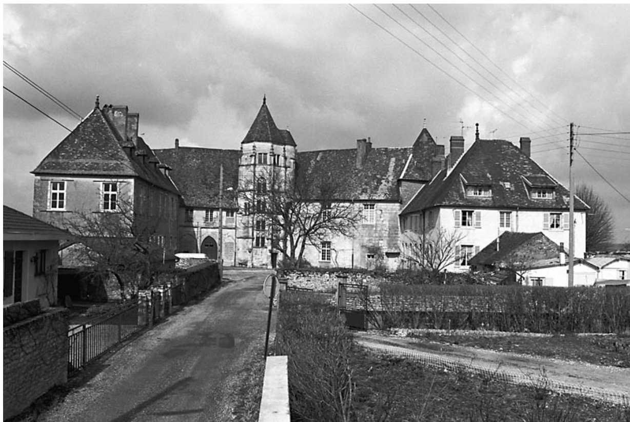
Façade antérieure sur cour.
