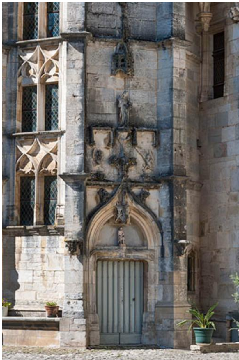
Porte de la tour d'escalier
