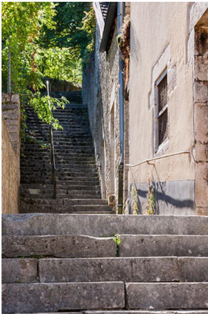
Escalier reliant la Grande Rue au château
