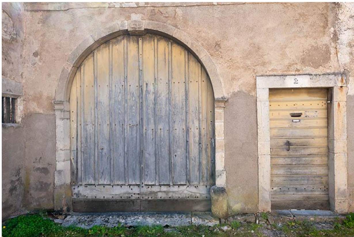
Détail du porche situé rue de l'Eglise 70, Gy
