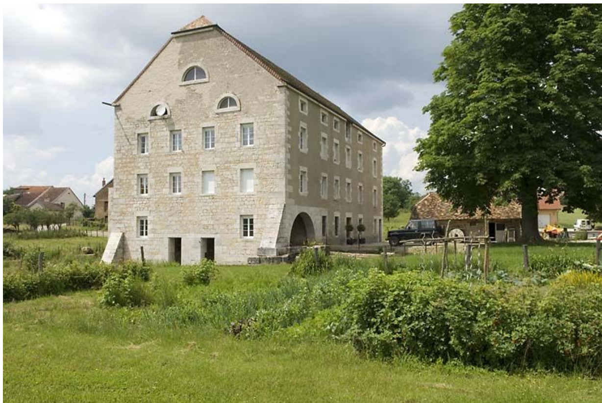
Vue rapprochée depuis le sud-est.
