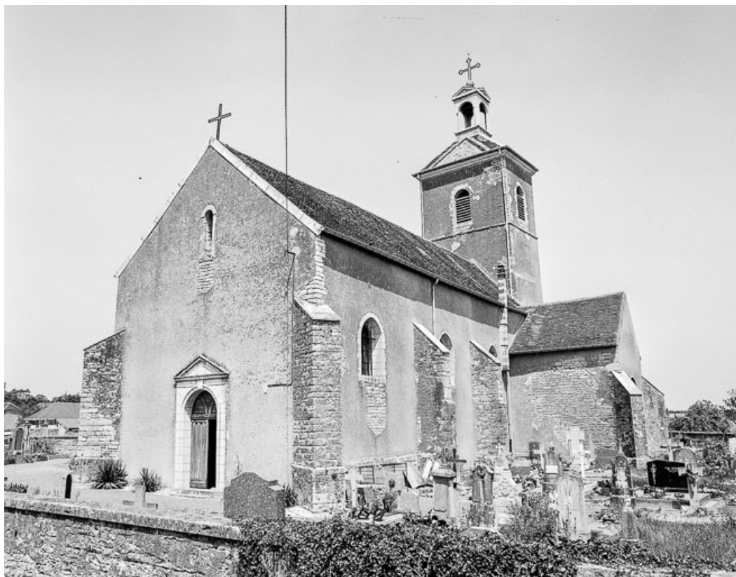
Façades antérieure et latérale droite.
