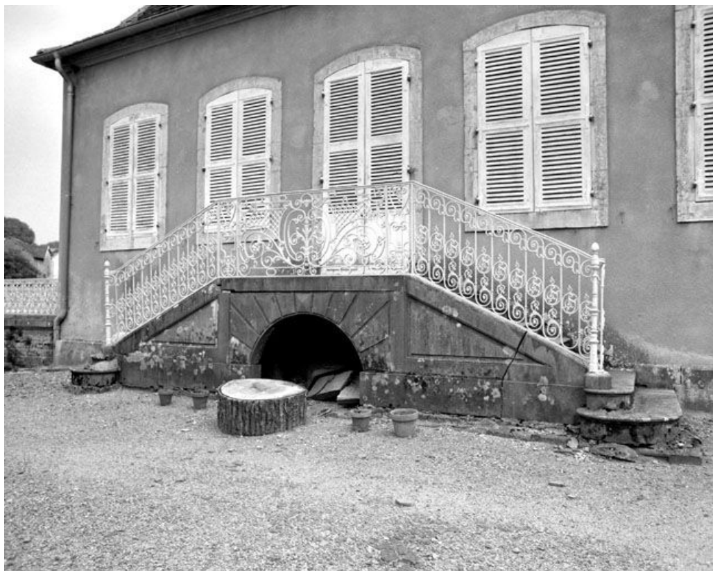
Façade droite du logis : détail du perron.
