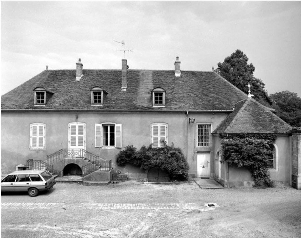
Façade antérieure du logis.
