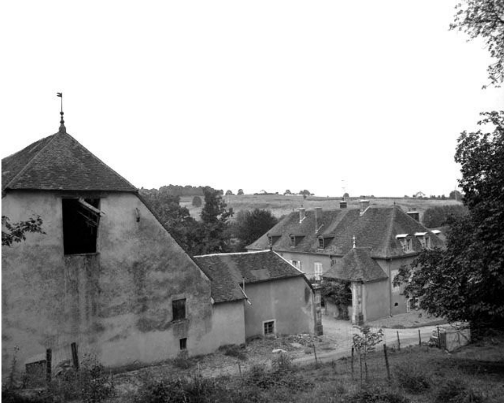
Vue depuis le sud-est.
