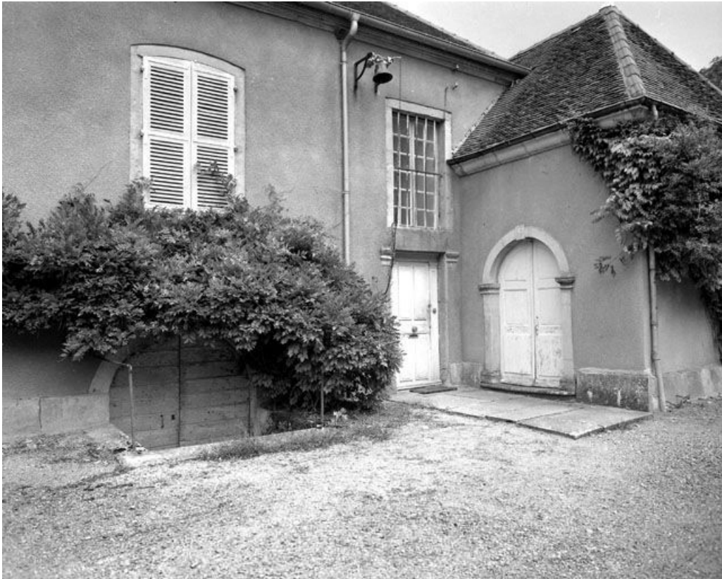
Façade antérieure du logis : partie droite.
