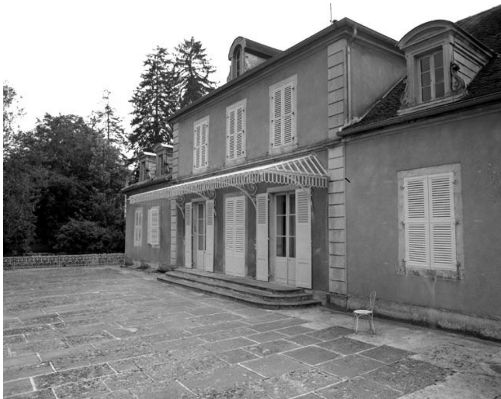
Façade principale du logis : vue de trois quarts droit.
