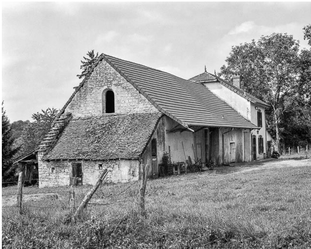
Vue de la chapelle.
