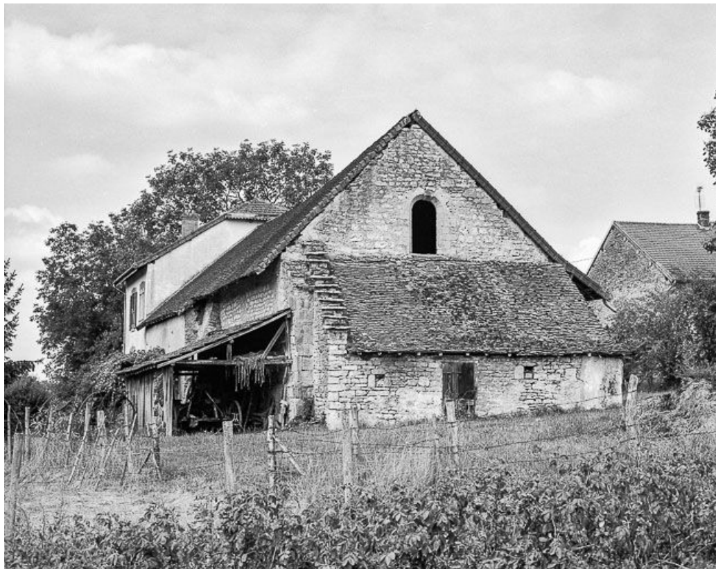
Vue de la chapelle.
