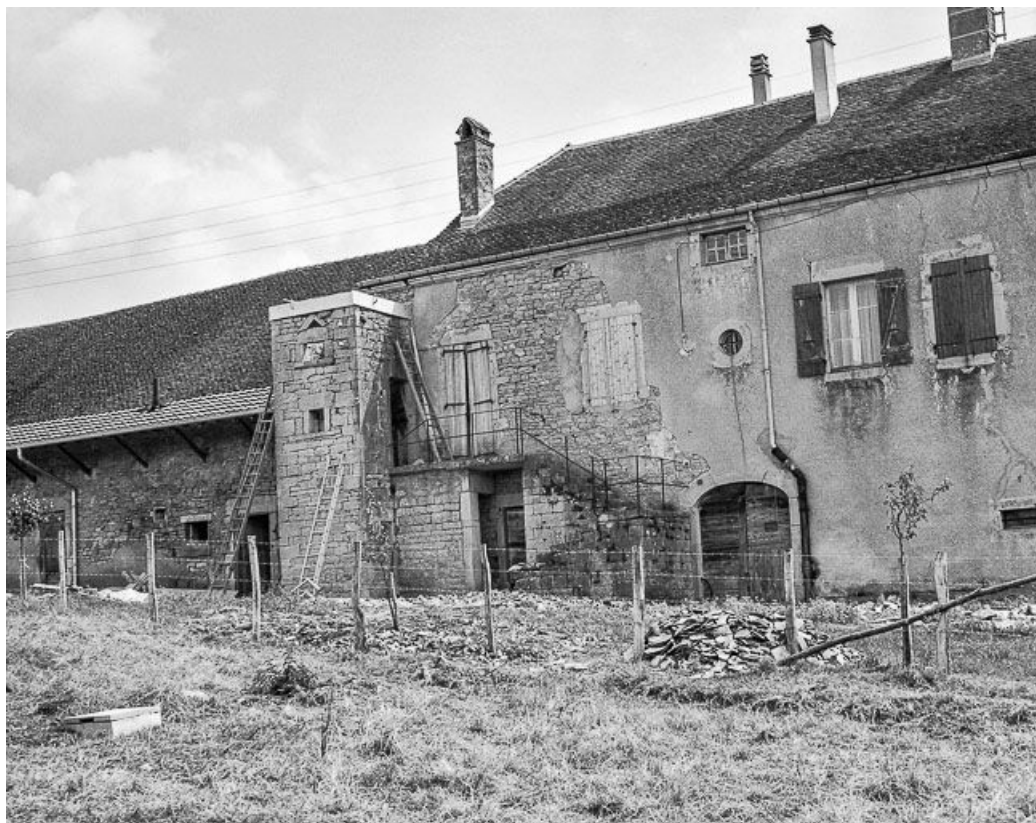
L'habitation, face postérieure.
