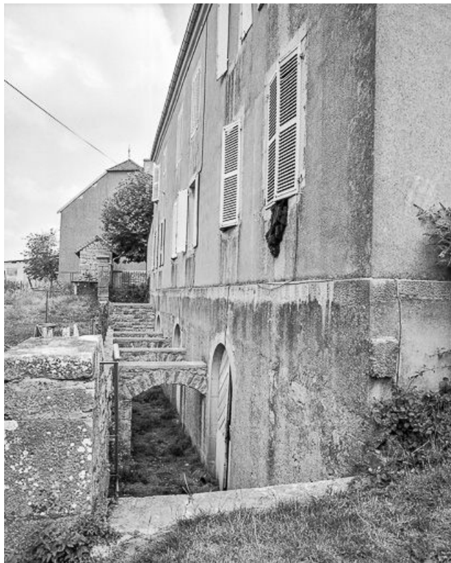
Détail du soubassement de la façade postérieure.
