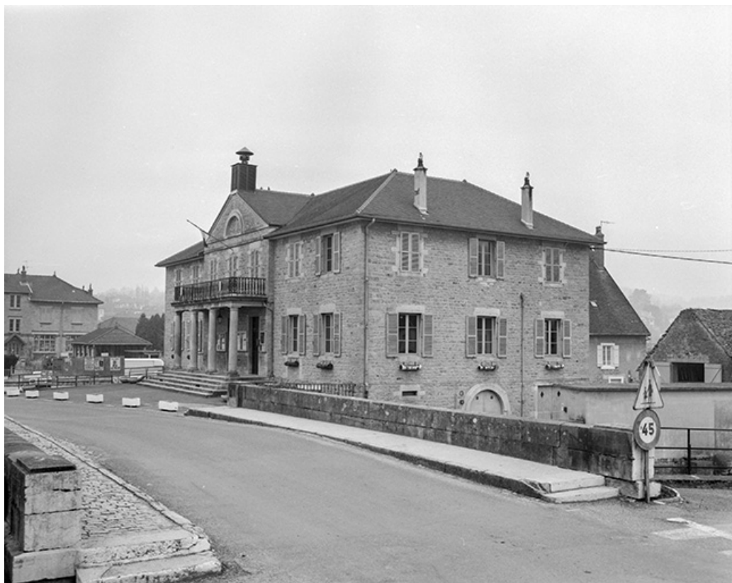
Façade antérieure et face droite.
